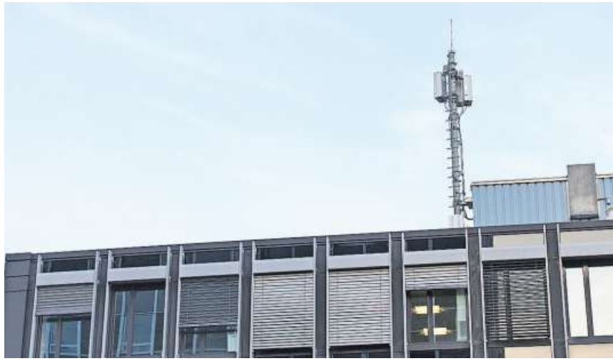
Eine der ersten 5G-Antennen im Bezirk wurde in Baden installiert. Bild: Claudio Thoma
