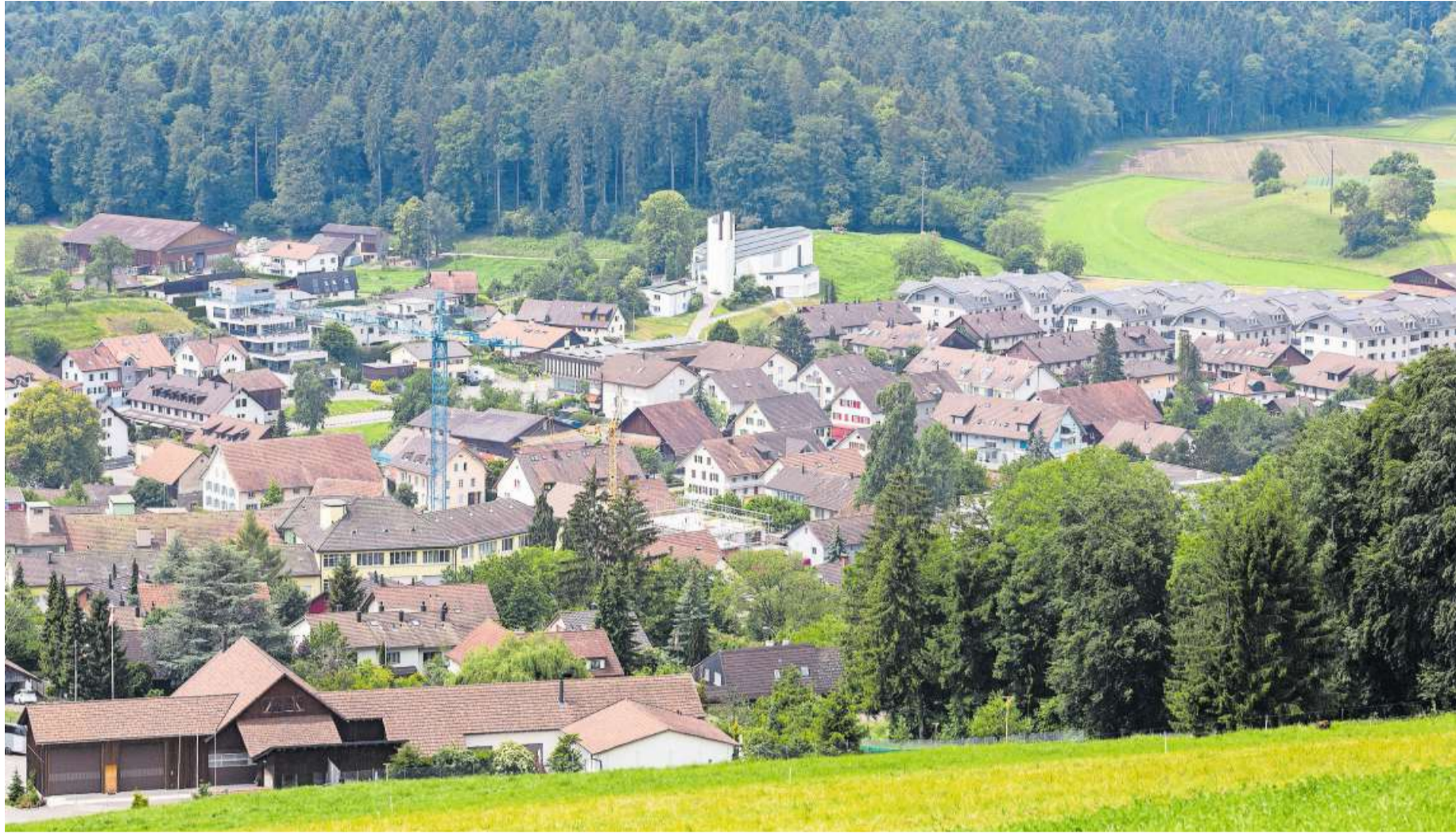
Ausreichender Handyempfang ist in Künten ein Problem. Nördlich des Wohngebiets beim Pumpwerk Forchhölzli ist nun eine Handy-Antenne geplant.
