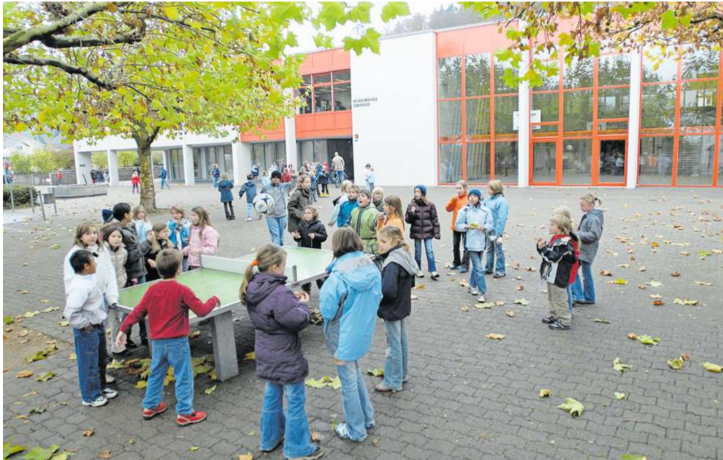
«Der falsche Standort für eine Mobilfunkantenne»: Die Schulanlage in Mägenwil.
