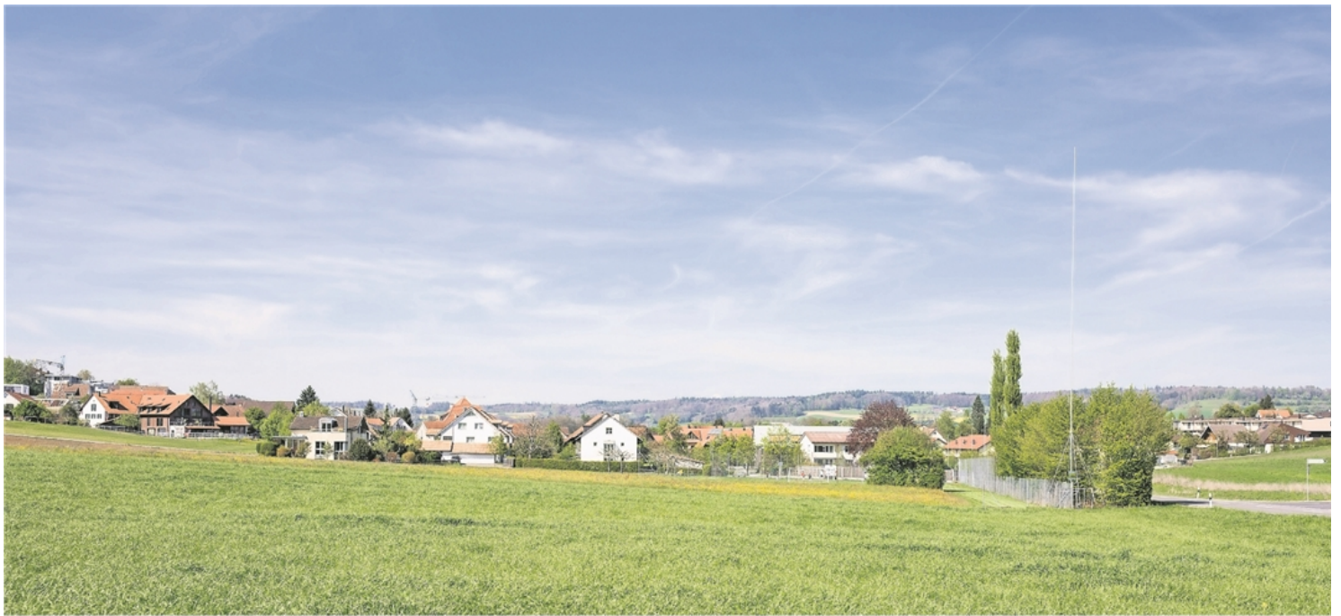
25 Meter hoch ist das Antennen-Gerüst, das vom Hertenstein her eingangs Freienwil neben der Hauptstrasse steht.
