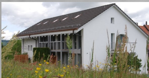
Ortsbürgerhaus in Freienwil
