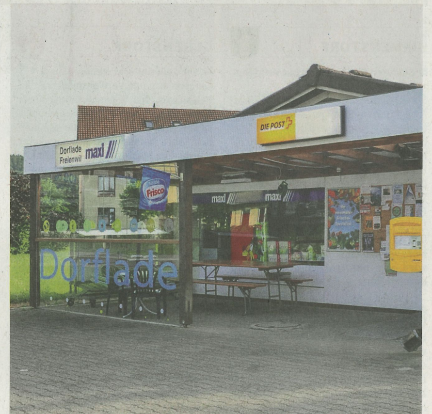
Der Dorfladen Freienwil muss noch im baufälligen Provisorium ausharren BILD: ZVG
