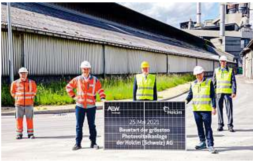
Baustart der PV-Anlage auf den Dächern des Zementwerks Siggenthal
