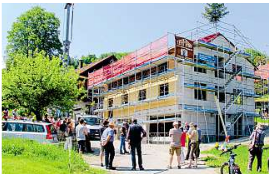
Die Aufrichte des Ersatzneubaus «Haus 36» konnte gefeiert werden
