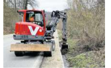
Kleintierunterführungen werden mit Baggern vorbereitet. Bild: zvg
