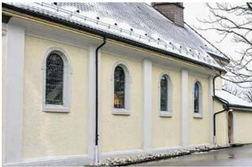
Die Gitter vor den Fenstern wurden durch Sicherheitsglas ersetzt
