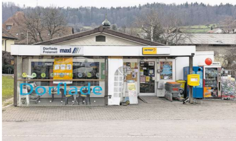
Der Dorfladen ist schon länger baufällig, muss aber noch ein paar Jahre halten.
