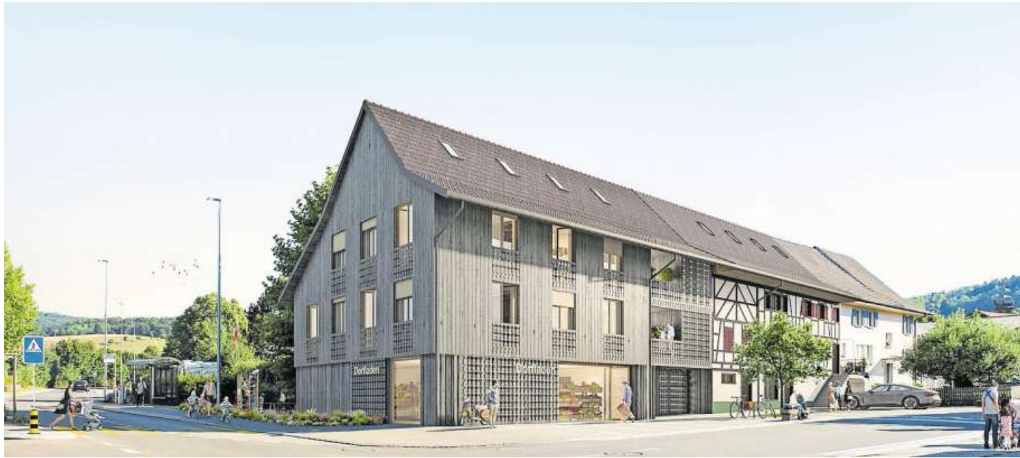
Ein eindrücklicher Bau an der Ortsdurchfahrt: Über dem neuen Dorfladen in Freienwil entstehen vier Mietwohnungen.
