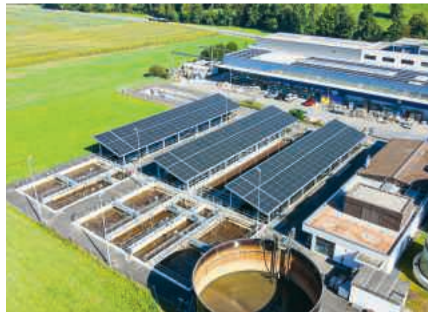
Die Schrägdachkonstruktion mit Photovoltaik über den Nachklärbecken
