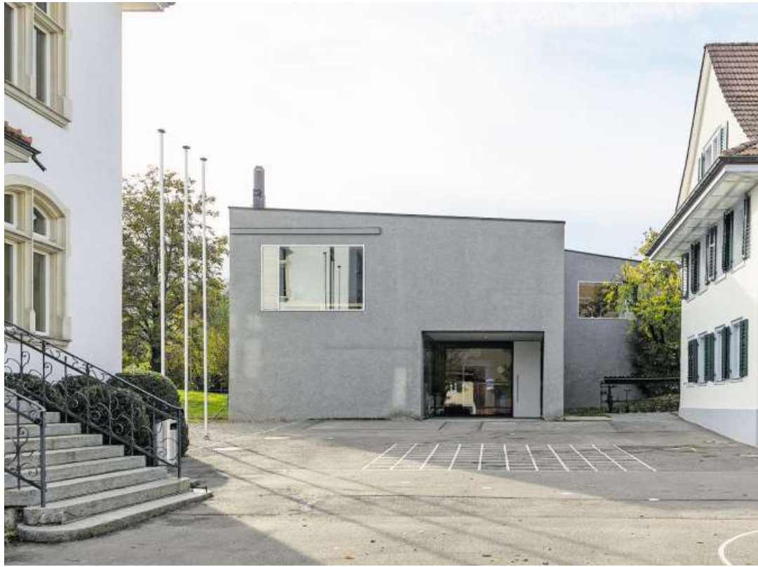
Die Holzschmelzheizung befindet sich im Keller des neuen Schulgebäudes. Der Rauch entweicht über den Kamin auf dem Dach. Bild: Sandra Ardizzone
