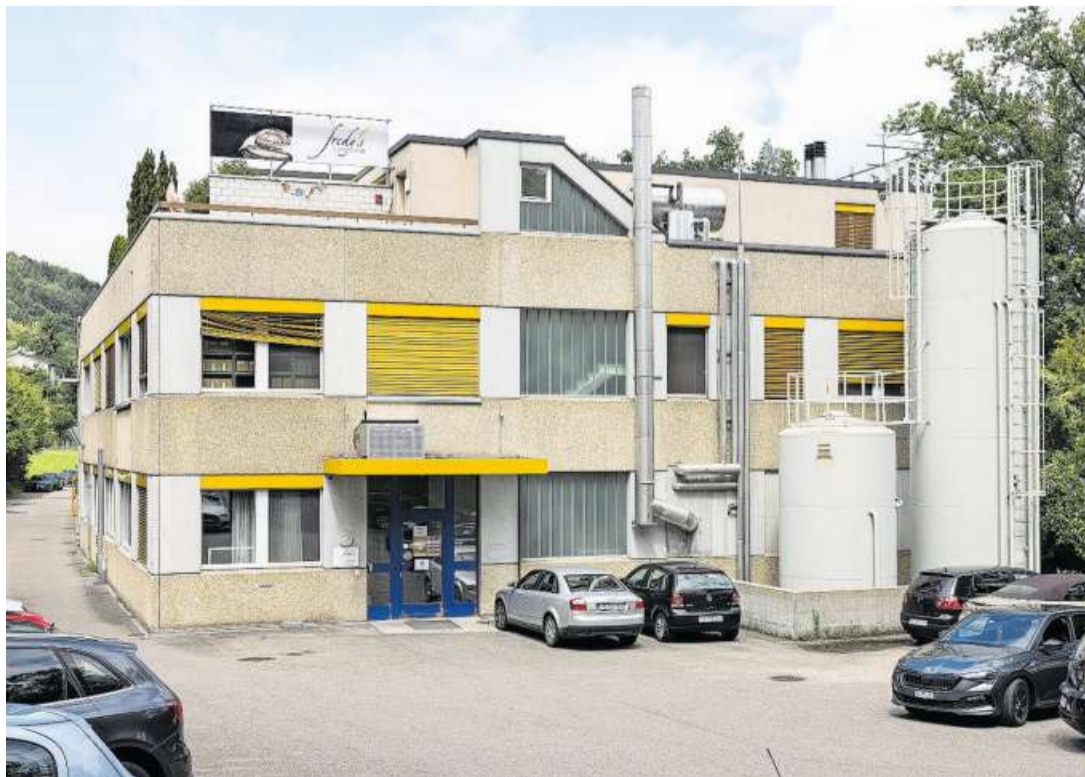
Unter anderem will die Fredy's AG diese beiden Mehlsilos ersetzen.
