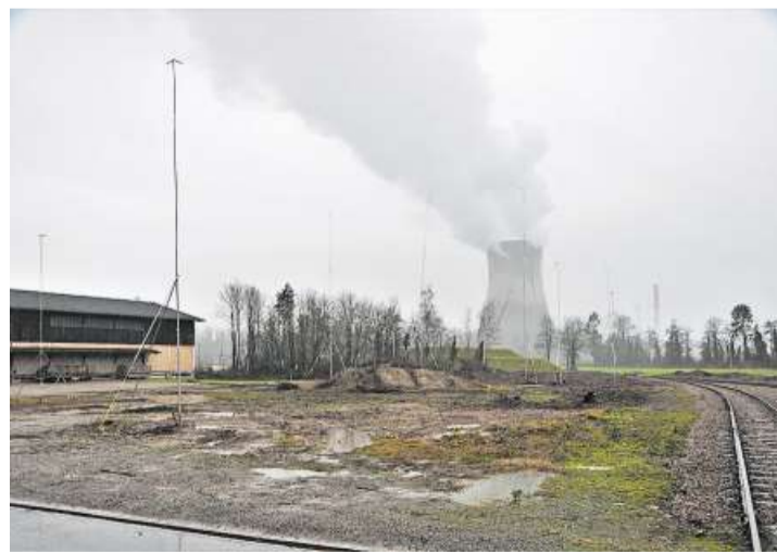
Ende Jahr zeigten die Bauprofile den Standort der Anlage an. Bild: pz
