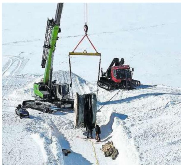
Das beheizte Rohr der BRUGG Pipes wurde mithilfe eines Krans und einem Pistenbully verlegt.
