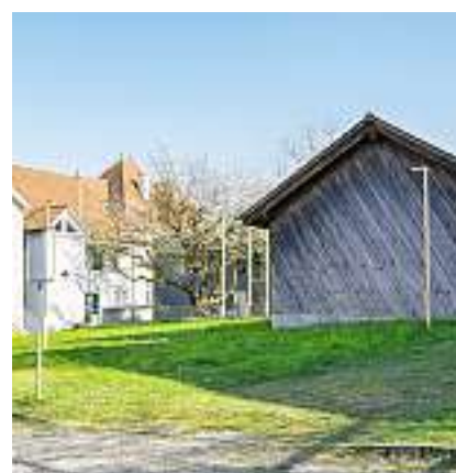
Die Bauprofile für den Schulcontainer bleiben weiter stehen
