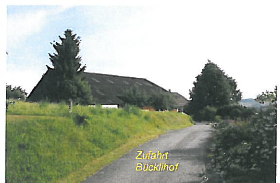
Bestehende Stichstrasse zum Ökonomiegebäude
