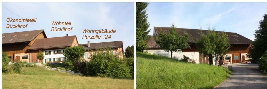
Bestehende Wohnbauten und Ökonomieteil
