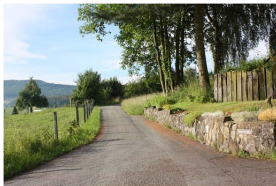
Rückwärtige Zu- und Wegfahrt Reservoirweg
