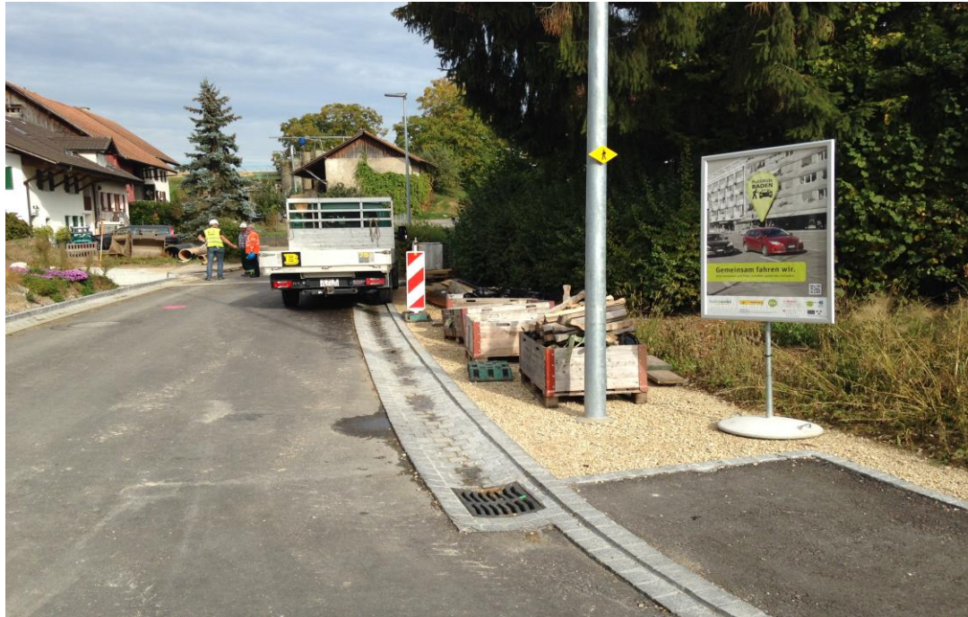
Abbildung 7: Ausgeführte Entwässerungsrinne Alte Ehrendingerstrasse (Oktober 2015)
