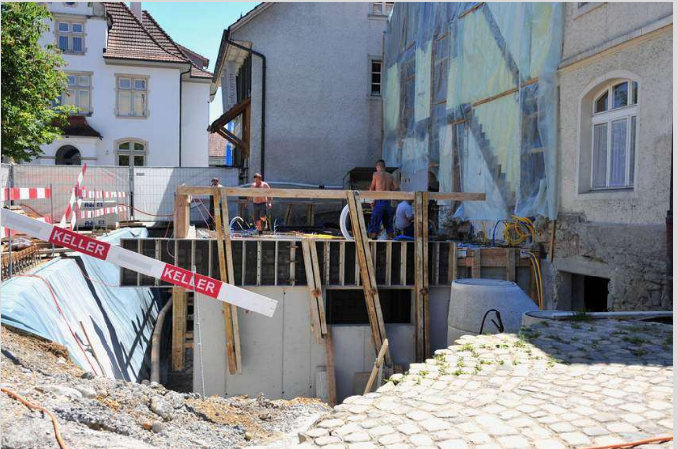
Die Baustelle Weisser Wind Ende Mai: Das Fundament steht, bald wird der neue Anbau errichtet sein (Bild: zVg/Sabrina Pugliatti)
