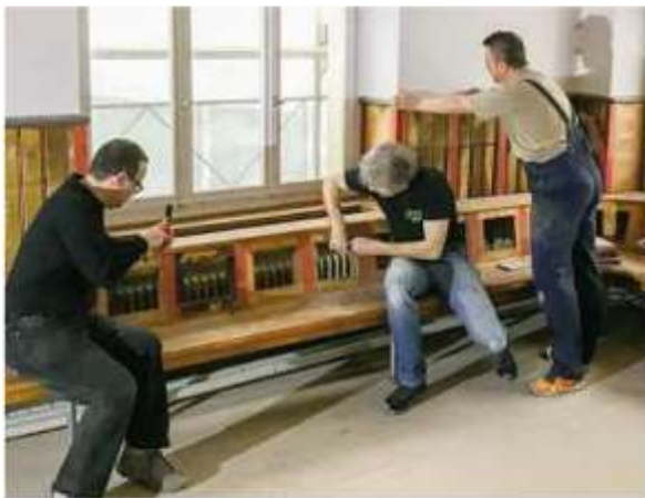
Arbeiten: Die Zeit wird knapp: Am Wochenende packten auch Genossenschaftsmitglieder auf der Baustelle im Restaurant an
